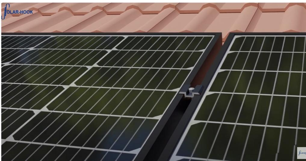
Nun schieben Sie die Endklemmen auf beiden Seiten ebenfalls ganz an die Module heran und ziehen Sie fest. – Endklemmen werden mit einem Drehmoment von 10 Nm angezogen.
