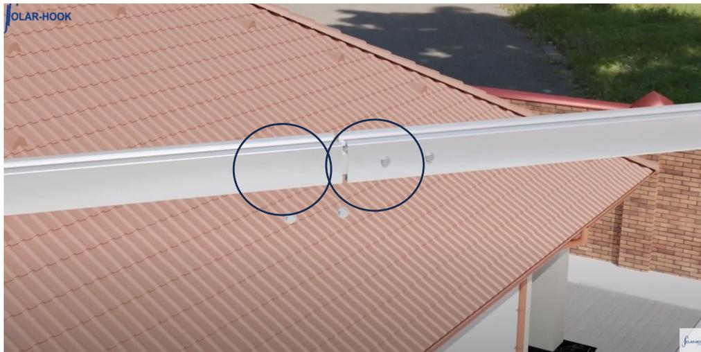
Dann Aluminiumprofile umdrehen und auf der gegenüberliegenden Seite ebenfalls mit 4 selbstschneidenden Schrauben sichern.
