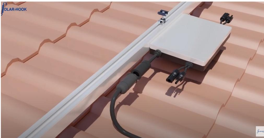
Verbinden Sie nun die DC-Kabel ihrer Photovoltaik-Module mit dem Wechselrichter.
